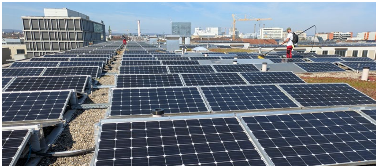
Reinigung der PV-Anlage Erlenmatt E in Basel, Foto: Lorenz Matter
