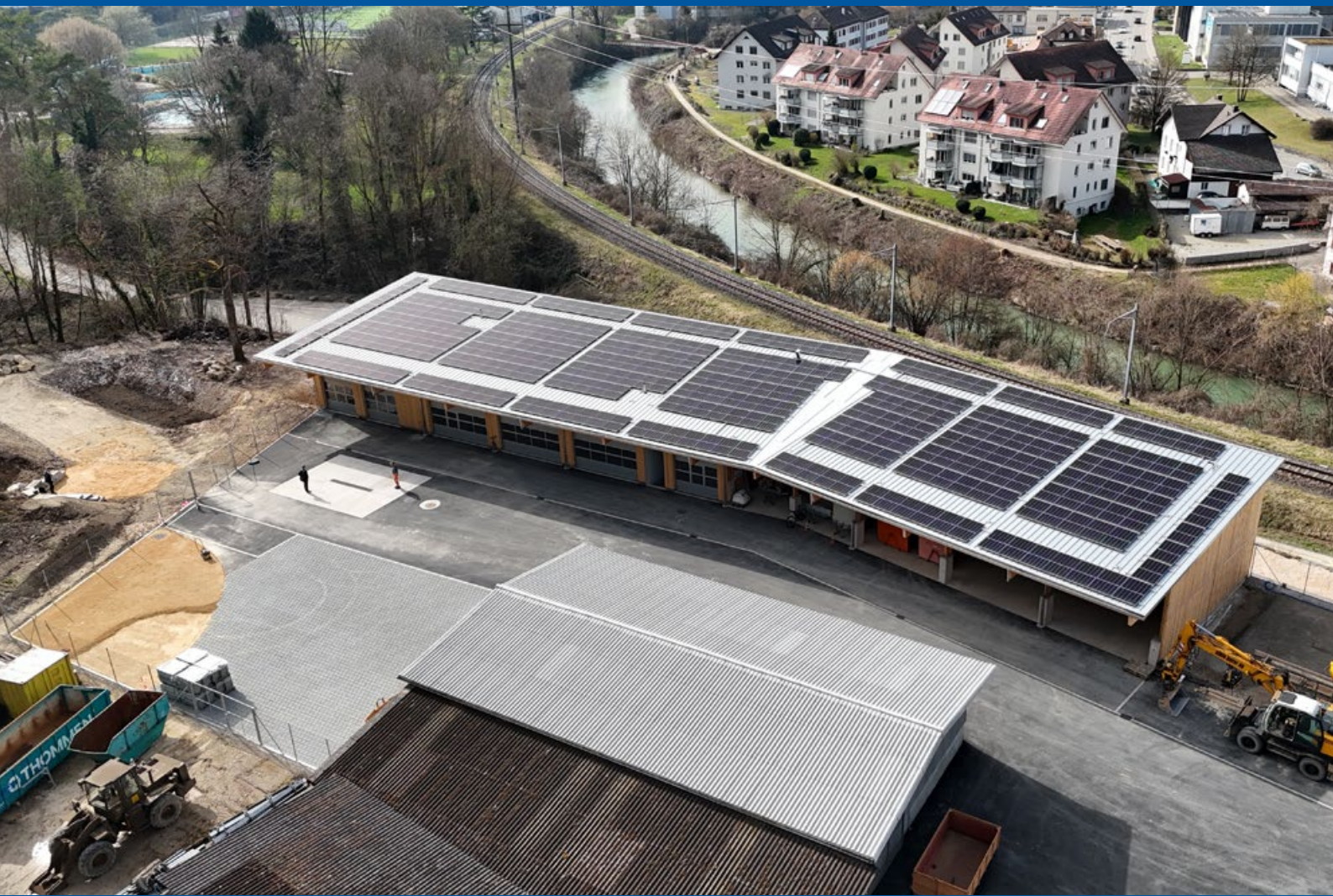
Letzte Umgebungsarbeiten am Werkhof in Laufen, Foto: Lars Blumberg
